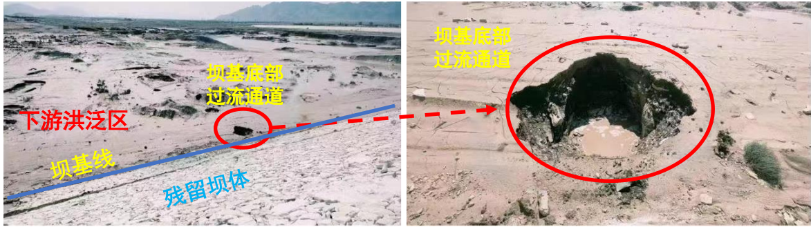
(b) 大坝底部过流通道
