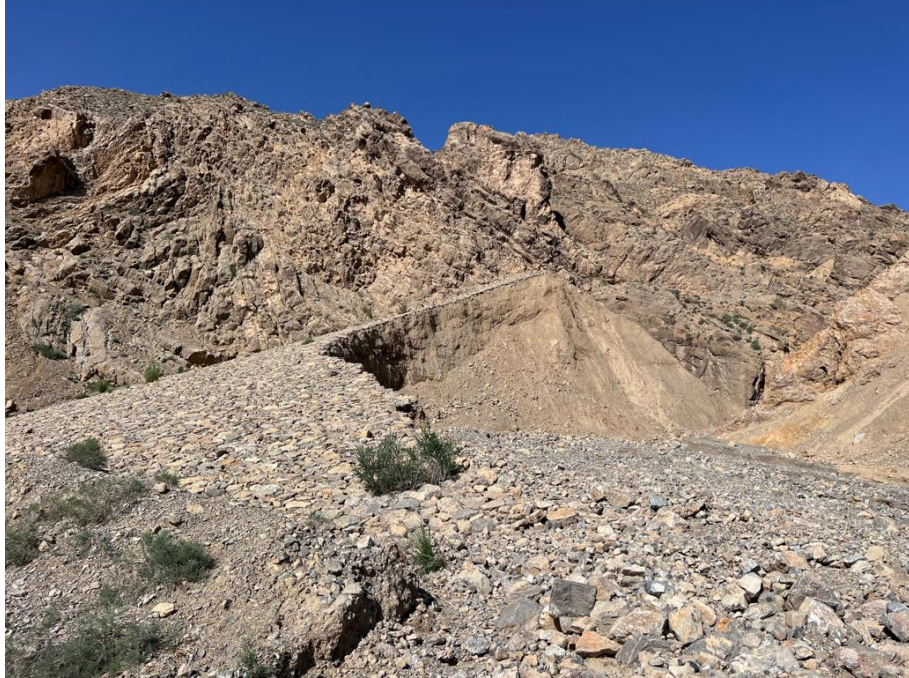
图 5 模式二：坝体渗流导致坝体溃决（Shallah Abad Dam，中巴中心供图）
