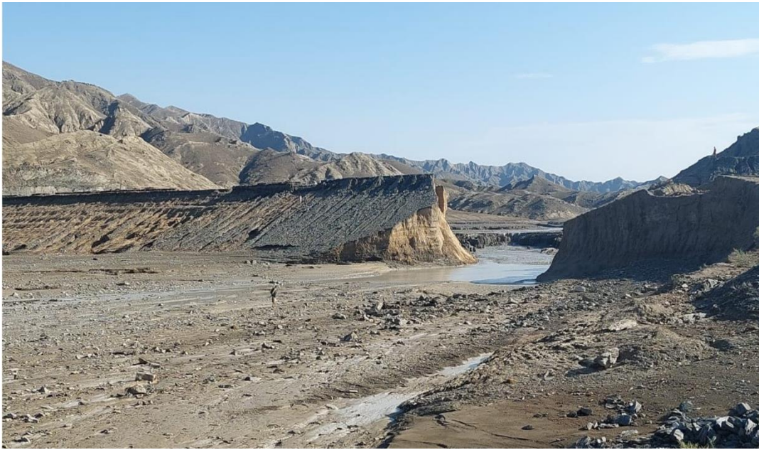
图 4 模式一：漫顶溢流导致坝体溃决（Machka Dam，中巴中心供图）
